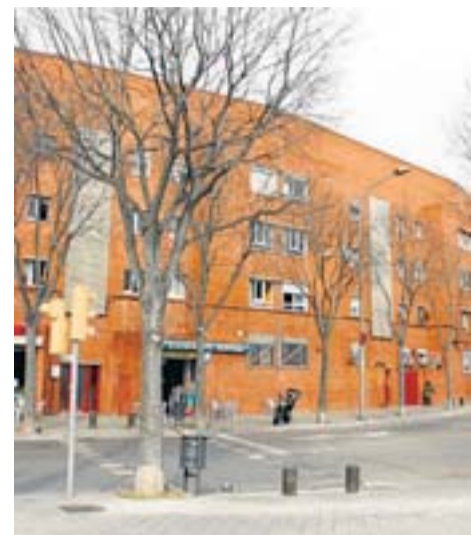
L'edifici tirotejat al carrer d'Oristà del barri de Vallbona de Barcelona. ACN
